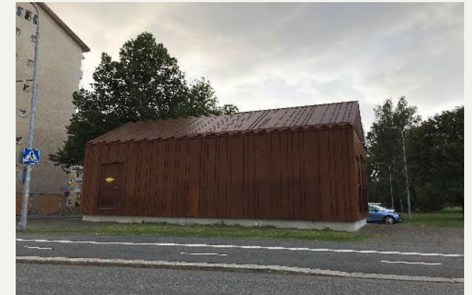
Kuva: Esimerkki sähkösyöttöasemasta Tampereen raitiotien osalta 1.
