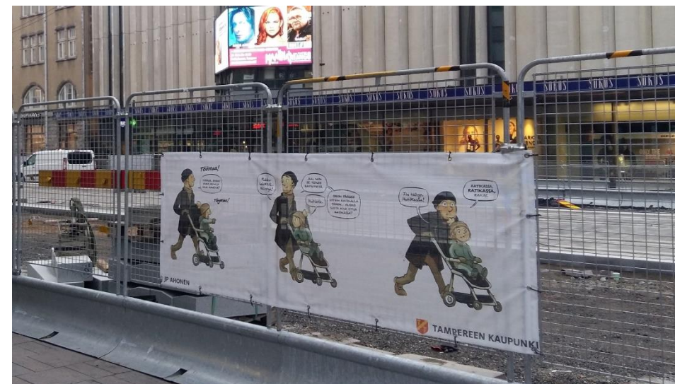
Väliaikaista taidetta Hämeenkadun työmaalla. Kuva: Raitiotieallianssi.
