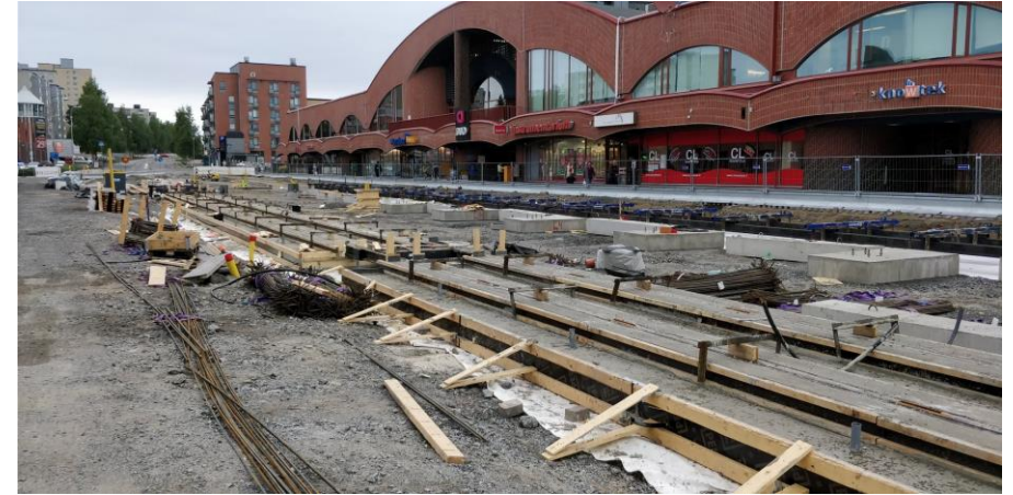
Työmaa Hervantakeskuksen kohdalla. Kuva: Raitiotieallianssi
