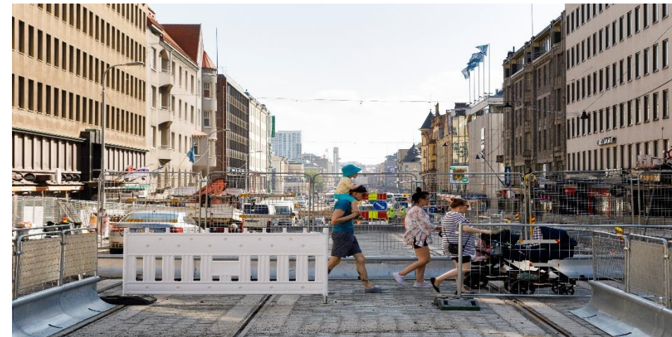
Hämeenkadun työmaa. Kuva: Pasi Tiitola / Raitiotieallianssi.
