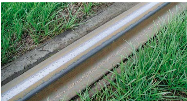
Kuva: Raitiotievaihtoehto mahdollistaa kadun päällystetyypin, jossa nurminauhat kulkevat kiskojen vieressä ja välissä ns. viher- tai nurmiratana. Viherratana tulee katkoksia pysäkki-, katuristeys- ja vaihtealueilla.
