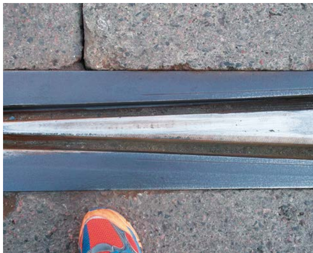
Kuva: Urakiskollinen kiintoraide rakennetaan osaksi kadun luonnonkivistä päällysrakennetta likimain muun kadunpinnan tasoon. Mikael Wuorinen.
