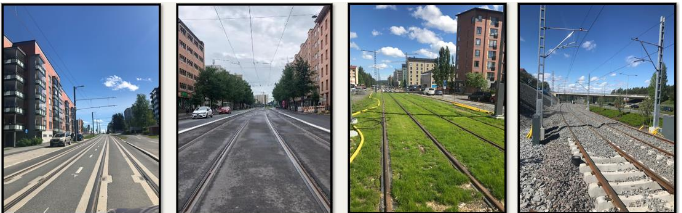
Kuva 4. Päällysrakenteet vasemmalta oikealle: sekaliikennerrata, raitiotierata, nurmirata ja sepelirata.
