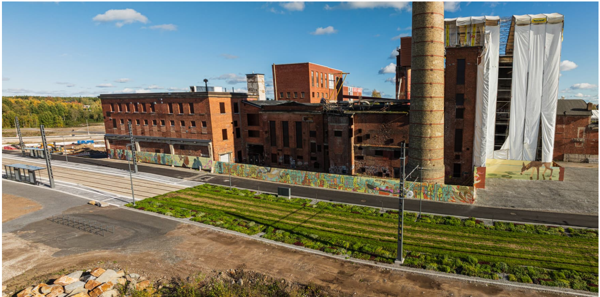
Kuva 2. Raitiotie Hiedanrannan vanhan tehdasrakennuksen kohdalla.
