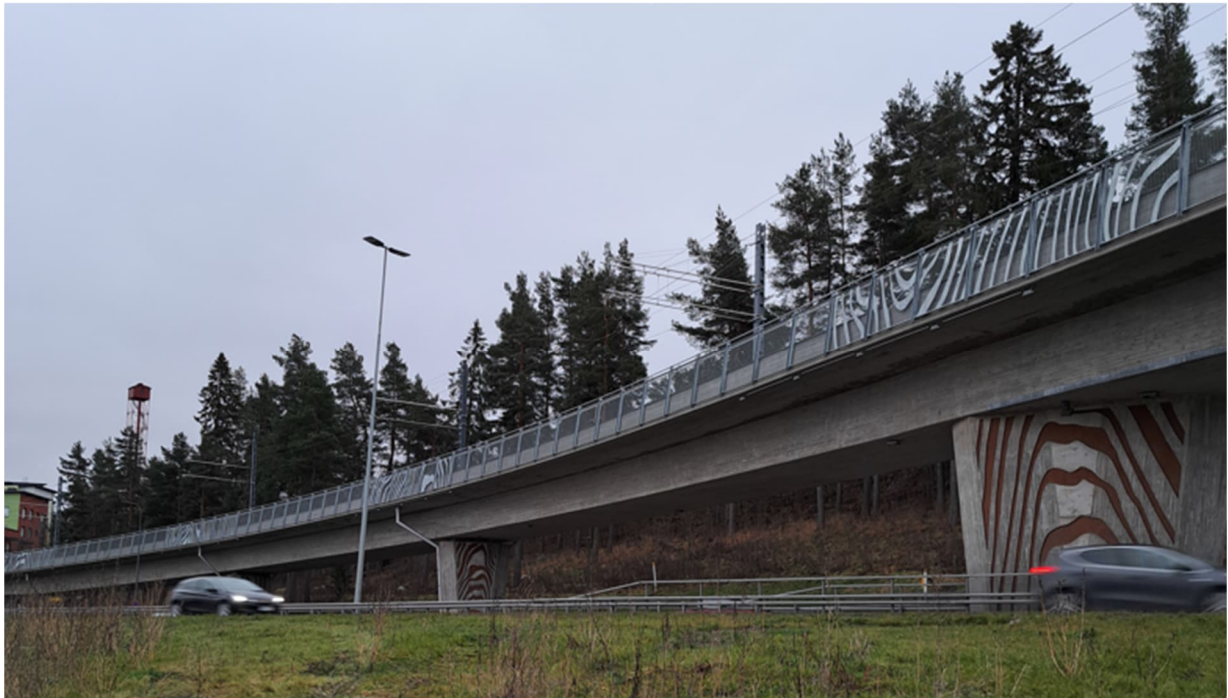
Kuva 12. Raitiotiesilta Pölkylänniemen suunnasta kuvattuna.
