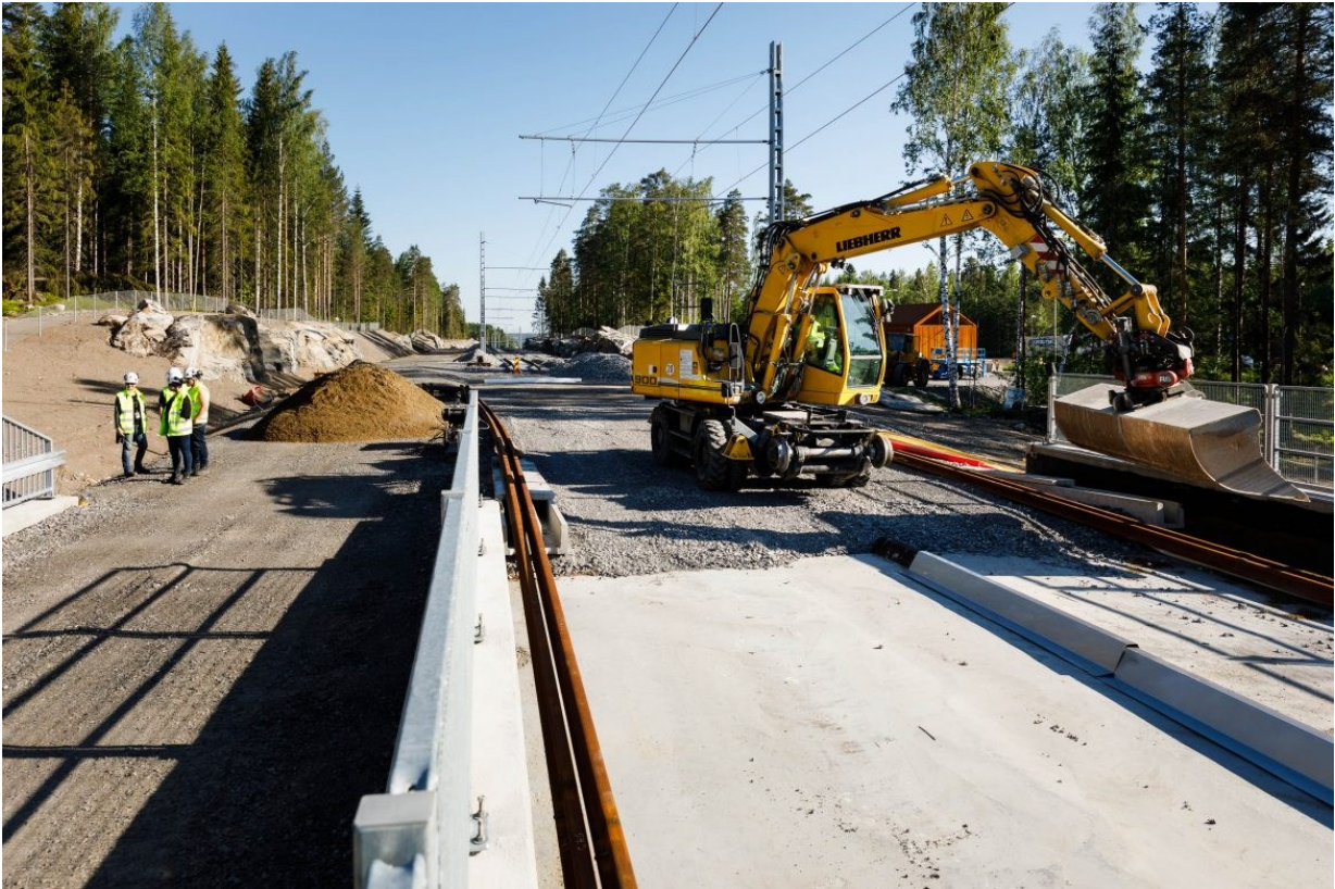
Kuva. Hallilassa on tehty osan 1 rakentamisen aikana kallioulouhintaa.
