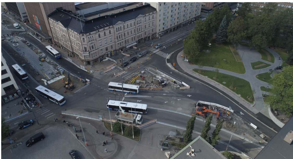
Kuva. Rakennustöitä lintuperspektiivistä katsottuna Hämeenkadun ja Itsenäisyydenkadun liittymäalueella.
