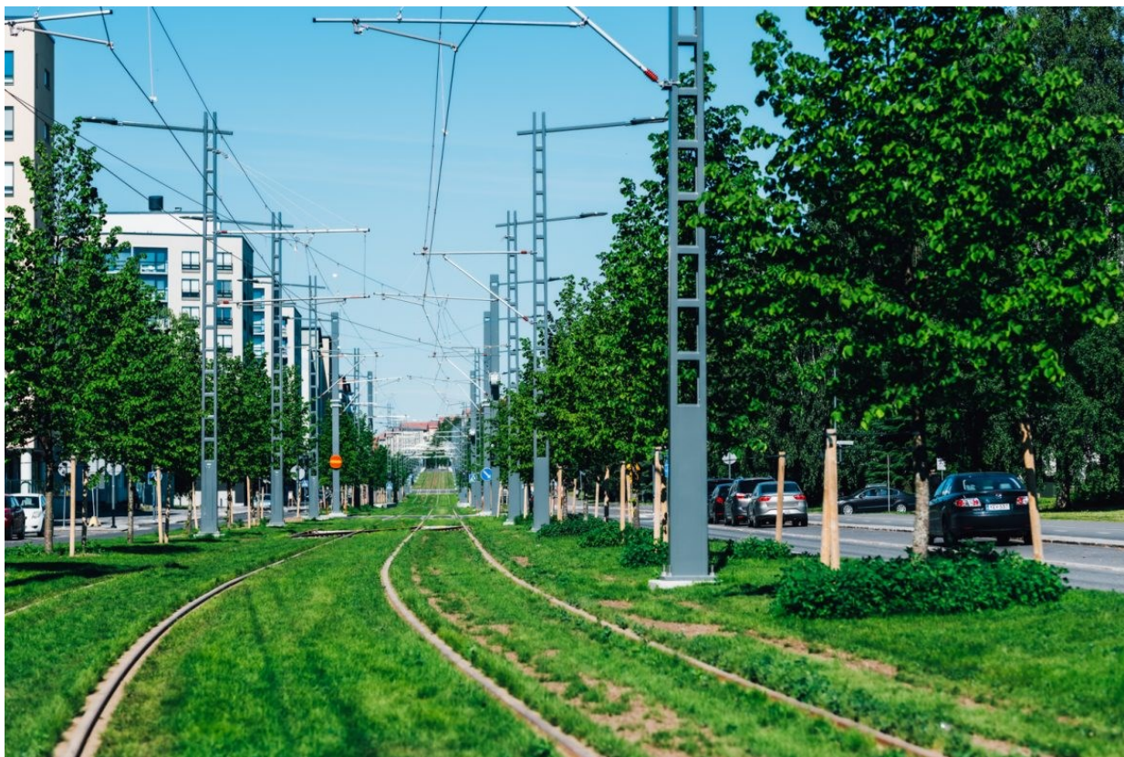
Kuva. Nurmiraata Sammonkadulla. Tikasmallinen yhteiskäyttöpylväs sopii hyvin keskustaympäristöön ja on ollut onnistunut valinta.
